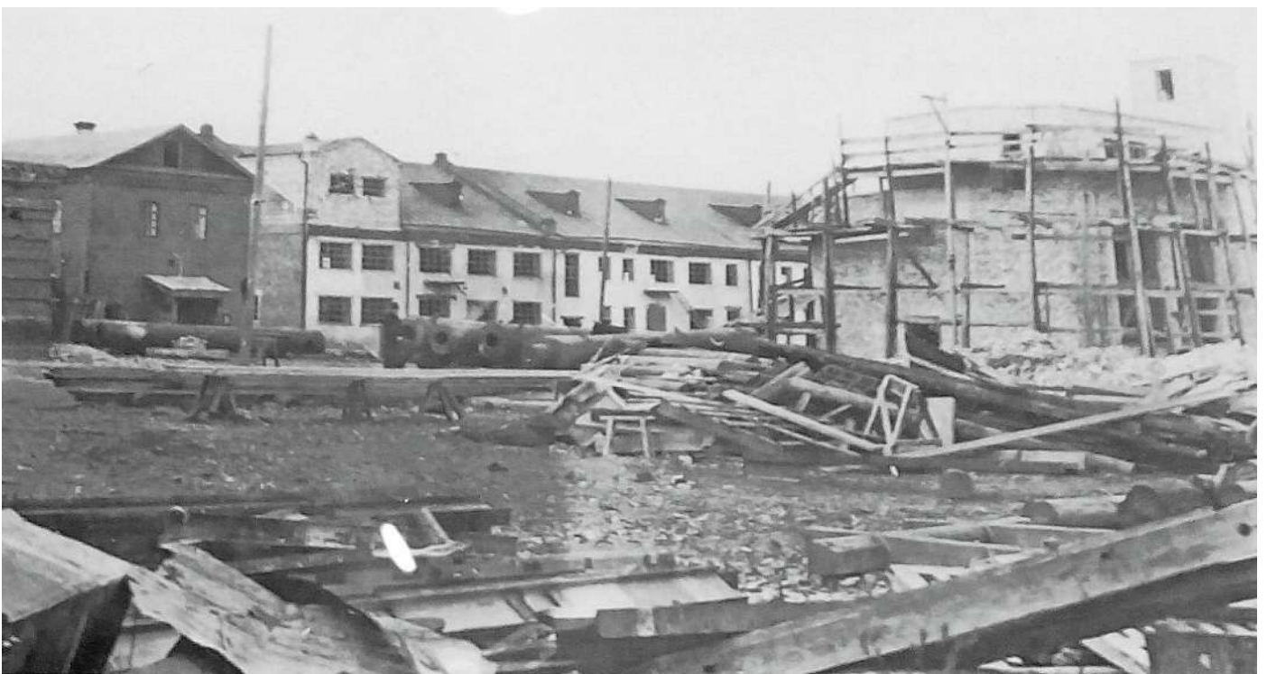
Строительство бисквитной фабрики. Благовещенск.
